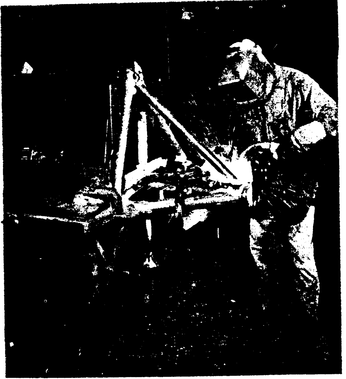
Şekil: 392. Kendini koruyan "açık ark" özlü tel elektrodla bir buldozer bıçağı için boru mesnet tertibinin kaynağı.
